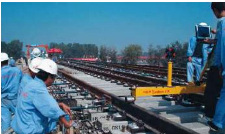
Рисунок 16 – Применение **Amberg Slab Track** при укладке пути
