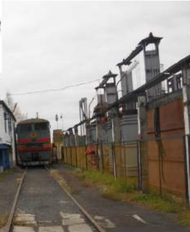
Станция реостатных испытаний тепловозов
